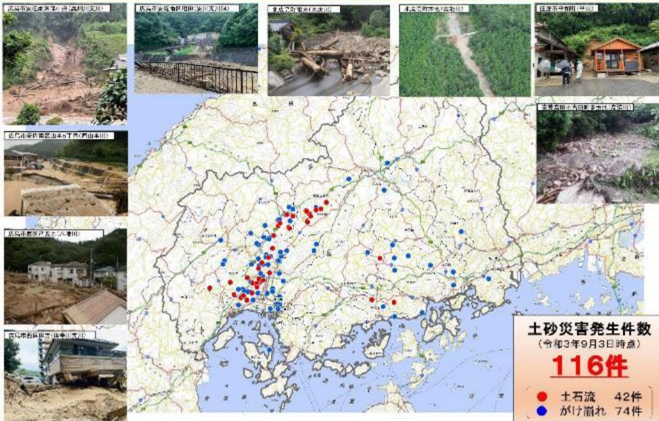
広島県土木建築局砂防課「令和3年8月豪雨による土砂災害の発生状況」
